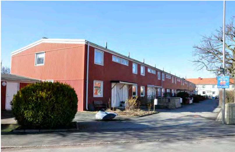
Radhuslänga på Elektrongatan med enkelt utförda fasader och ett flackt sadeltak.
